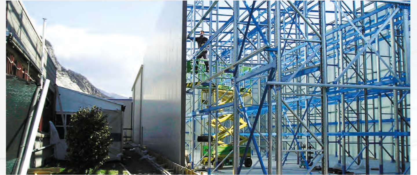
Cella BT su scaffalatura\Freezer room on shelvings
